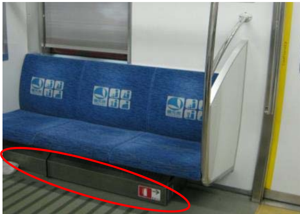
車内の消火器の位置
