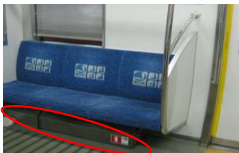
車内の消火器の位置
